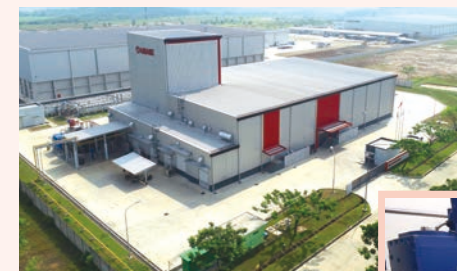
インドネシア工場外観
